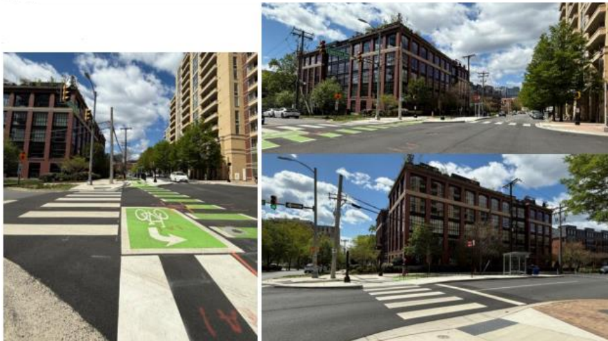
Proyecto de construcción rápida completado en Clarendon Blvd y N Queen St/N Pierce St
