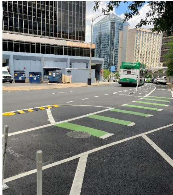
Mejoras de marcas en la calzada e instalación de postes flexibles y reductores elevados en el cruce con el giro a la derecha del carril bici cuesta abajo
