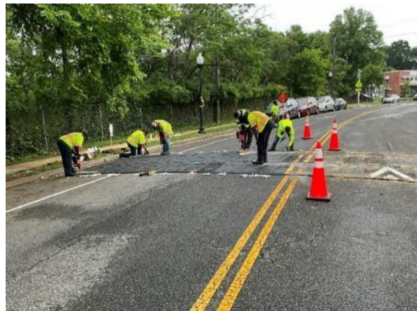
Instalación de reductor táctico de velocidad
