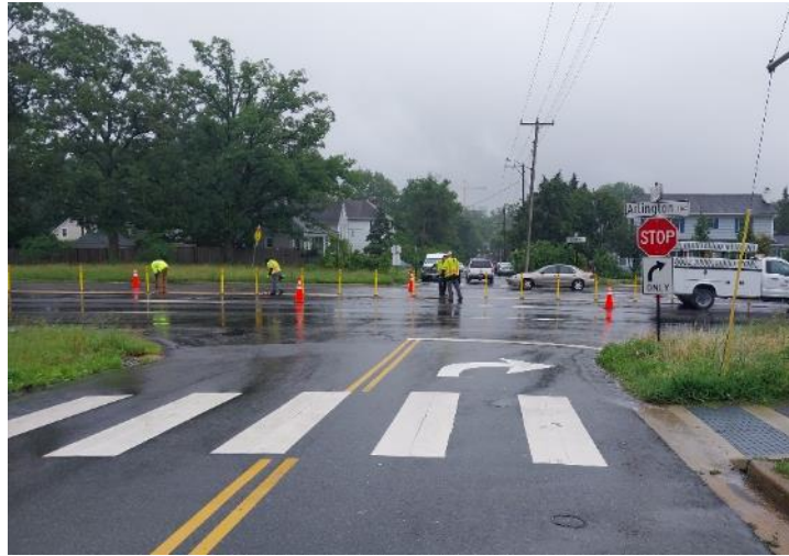
Instalación de cierre táctico de la mediana en la intersección de Route 50 y Highland St
