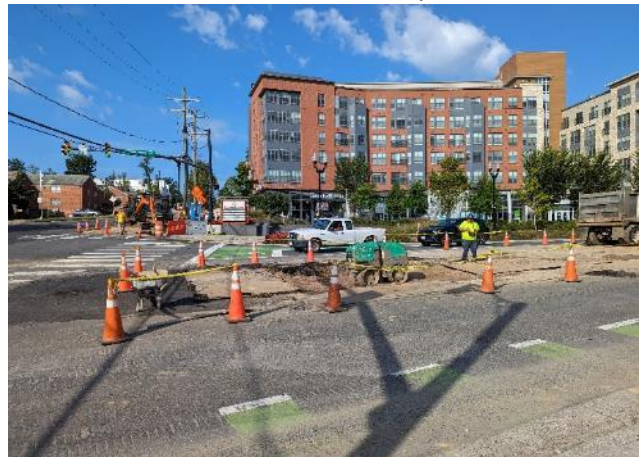
Obra de construcción en S George Mason Dr
